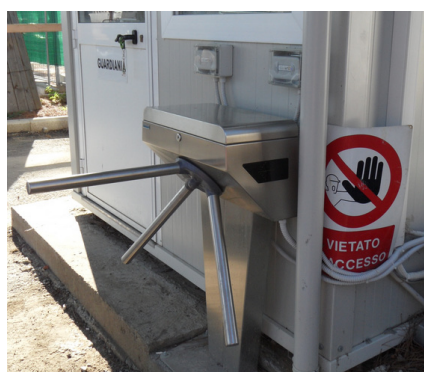
Esempio di varco pedonale
